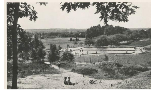
Het voormalige zwembad
